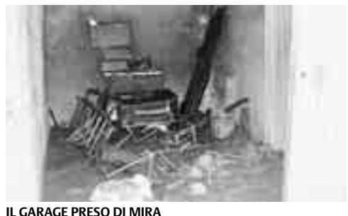
IL GARAGE PRESO DI MIRA
