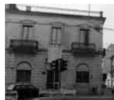
Il vecchio palazzo municipale di via Diaz, dove i malviventi sono entrati utilizzando la scala metallica dell'uscita di sicurezza
