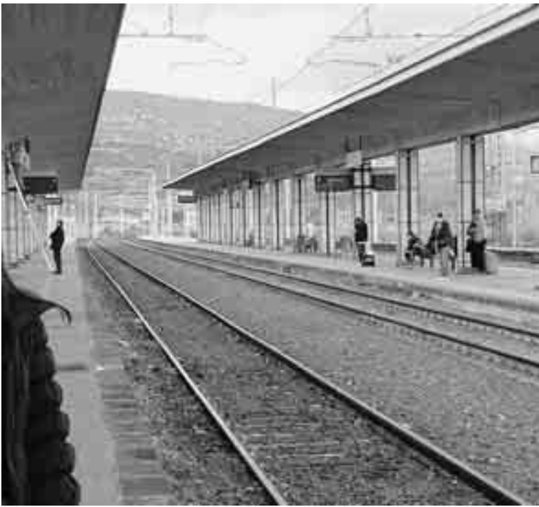
ASPETTARE UN TRENO ALLA STAZIONE DI GIARRE RISERVA QUALCHE BRUTTA SORPRESA
