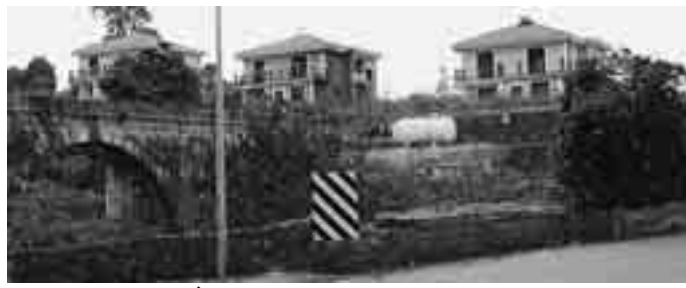
IL RESIDENZE DOVE SI È VERIFICATO L'INCENDIO [FOTO DI GUARDO]
