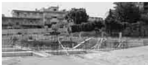
I lavori attualmente in corso nelle case di via Carducci Foto Di Guardo
