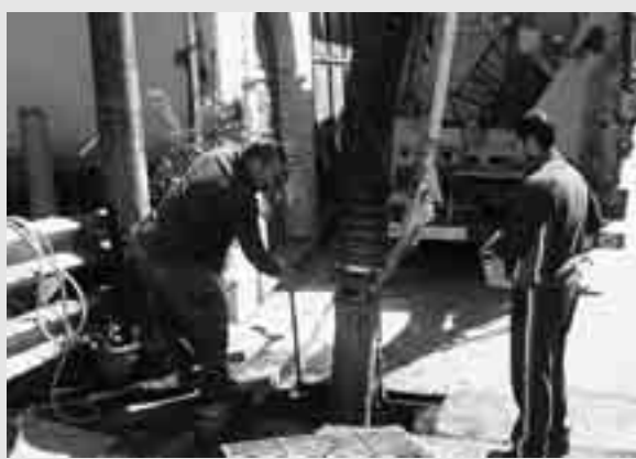
I lavori nelle caditoie effettuati con mezzi speciali che hanno permesso di spurgare anche 40 pozzetti al giorno (Di Guardo)
