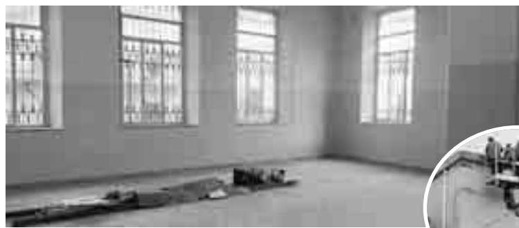
La palestra della scuola Verga (foto grande) e, nel riquadro, l'intervento dei vigili del fuoco nella scuola Don Bosco Foto Santo Di Guardo
