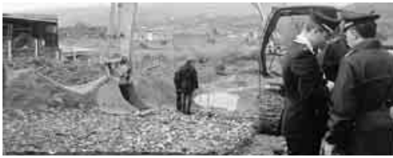
LAVORI PER LA REALIZZAZIONE DELL'AREA MERCATALE A CALATABIANO
