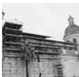
LAVORI AL DUOMO [DI GUARDO]
