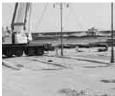
LAVORI NEL BACINO TURISTICO [DI GUARDO]
